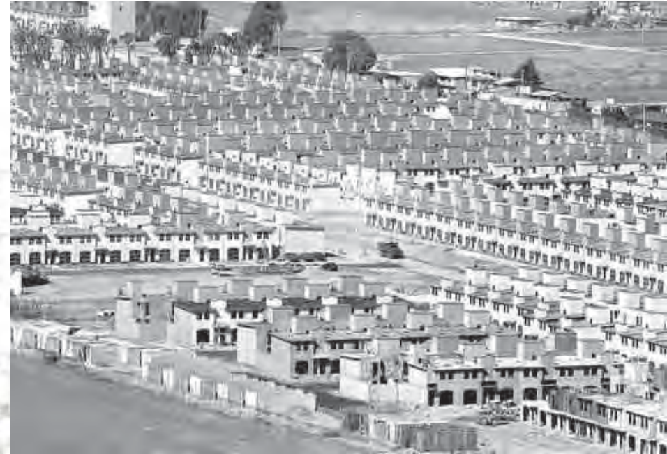
Figura 59. Vista aérea de un fraccionamiento en Toluca, estado de México.
