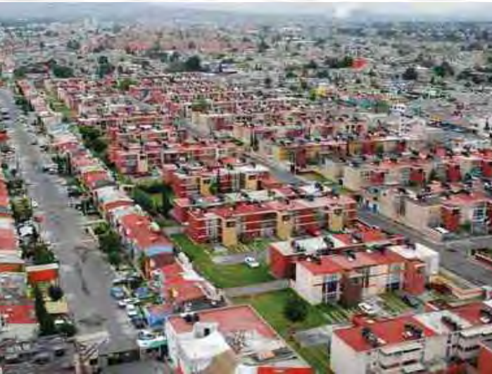
Figura 4. Vista panorámica conjunto Ecatepec.
