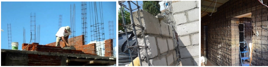
Figura 12. Fotografías de instalación de acero de refuerzo para distintas estructuras de mampostería.
