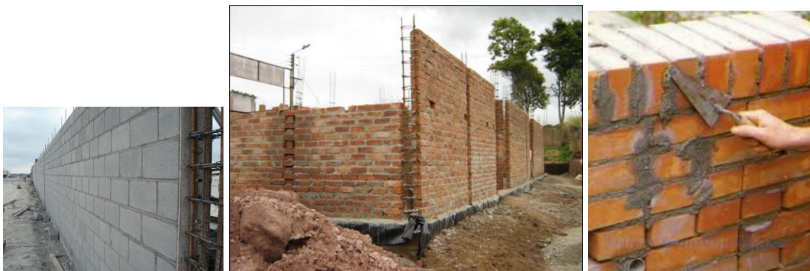
Figura 8. Ejemplos de muros de mampostería con aparejos (a) al hilo y (b) a tizón
