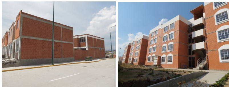
Figura 14. Ejemplo de Estructura Tipo I (imagen izquierda), y Estructura tipo II (imagen derecha) según las NTCM 2017
