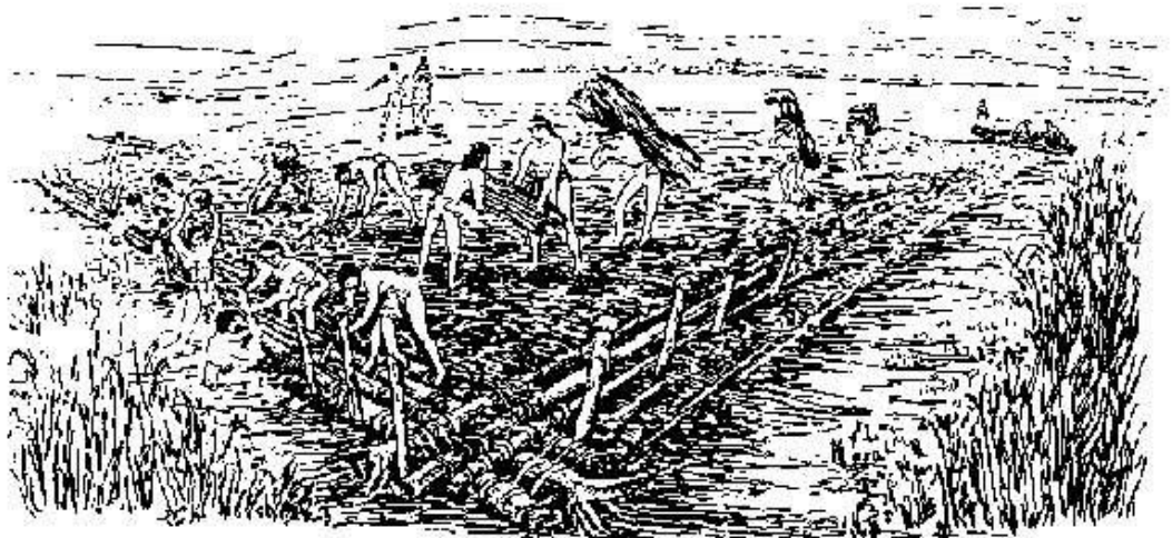
Imagen 2. Construcción de una chinampa prehispánica
