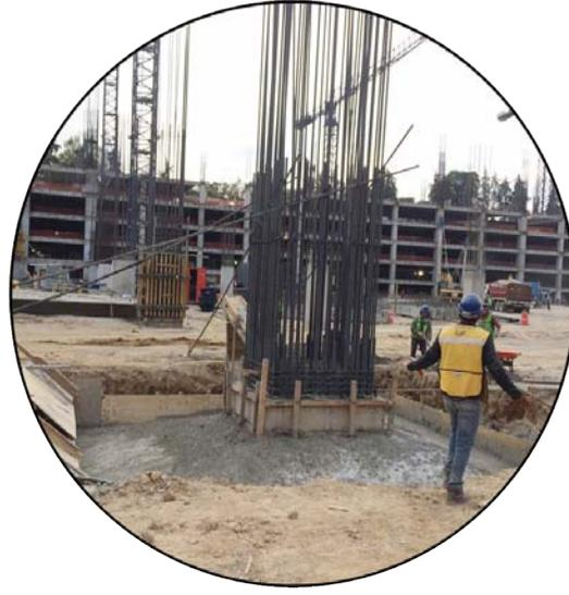
Z1- Zapatas de concreto armado reforzado para sostener las columnas del conjunto.
