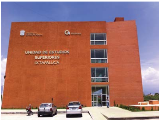
Fachada Oeste (acceso)
