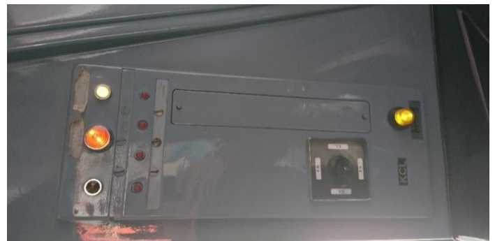
Figura 4.12 Avisos luminosos en el panel de fallas
