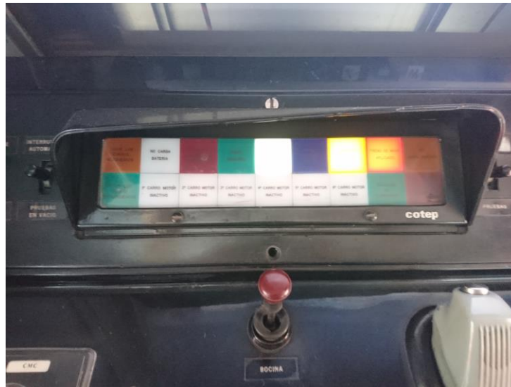
Figura 2.7 Cofre de fallas
