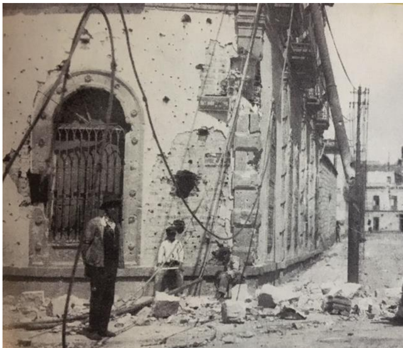
Fig. 3. Foto de Casasola y Ericsson. Fuente: Cervantes, 1963, p.61). Edificio ubicado en esquina Juárez y Balderas, en el que se pueden observar las huellas de las batallas en la “decena trágica” de 1913. Se aprecian los daños en las instalaciones de las compañías telefónicas (postes y cables).
