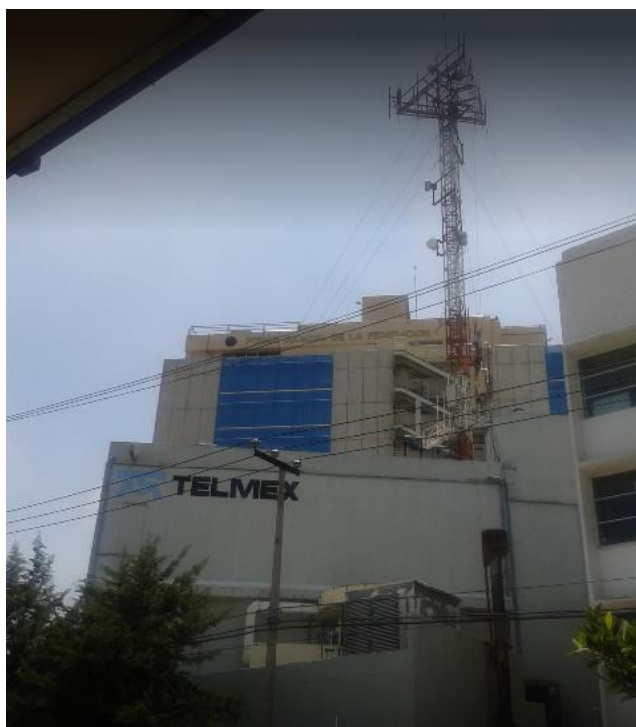
Fig. 6. Edificio de las centrales Coapa. Fotografía propiedad del autor de la Tesis
