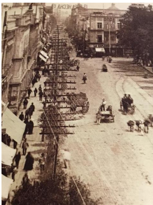
Fig. 1. Fotografía de Gove & North, 612. Fuente: Cuchi, 2013, p.149. Calle de Empedradillo, México, 1883. Actualmente esta calle se llama Monte de Piedad y está al costado poniente de la Catedral. Quizá fue tomada de la esquina de 16 de septiembre con Monte de Piedad hacia la Calle Republica de Brasil. En la porción izquierda de la foto se aprecia la red telefonía que utiliza postes de madera de más de 12 metros de altura y se puede observar la densidad de los postes y cables.
