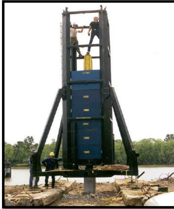
Figura 20.-Prueba estático-dinámica sobre pilotes de hormigón prefabricado (Handley & Bullivant, 2006)
