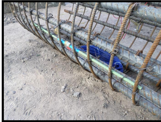
Figura 90.-“Deformímetros sister-bar” (CIMESA).
