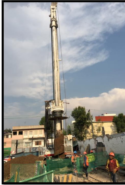
Figura 30.- Perforación en pila de 1.2 m de diámetro a 27 m (Lago Filt)
