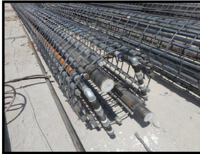
Figura 94.-Tubos de reservación para post-inyección (CIMESA)
