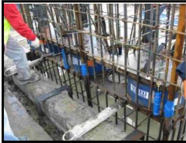
Figura 19.-Conjunto de celdas O-cell instalado de forma segura dentro de barrettes.(Melvin & Paul F., 2008)
