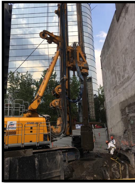
Figura 51.-Perforación LT-2 a -50 m.
