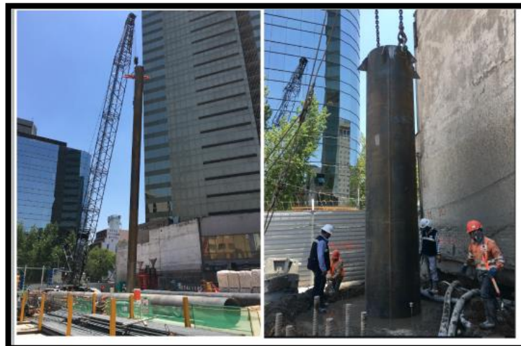
Figura 55.-Instalación de ademes (La fraga)
