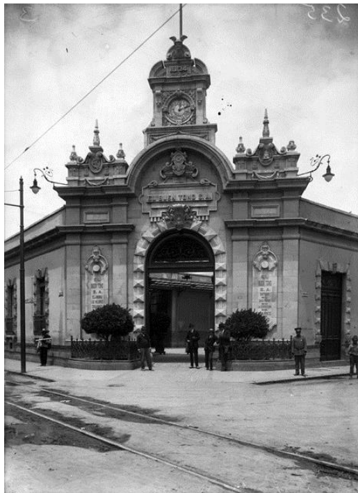
Imagen 2 Edificio de la Cigarrera El Buen Tono ubicado en la esquina de la segunda calle de San Antonio, fachada principal, México, D.F., Fototeca Nacional del INAH, ca. 1920.
