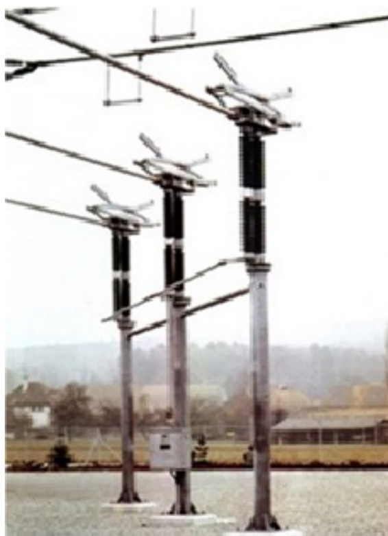
Figura 15: Seccionador pantógrafo.
