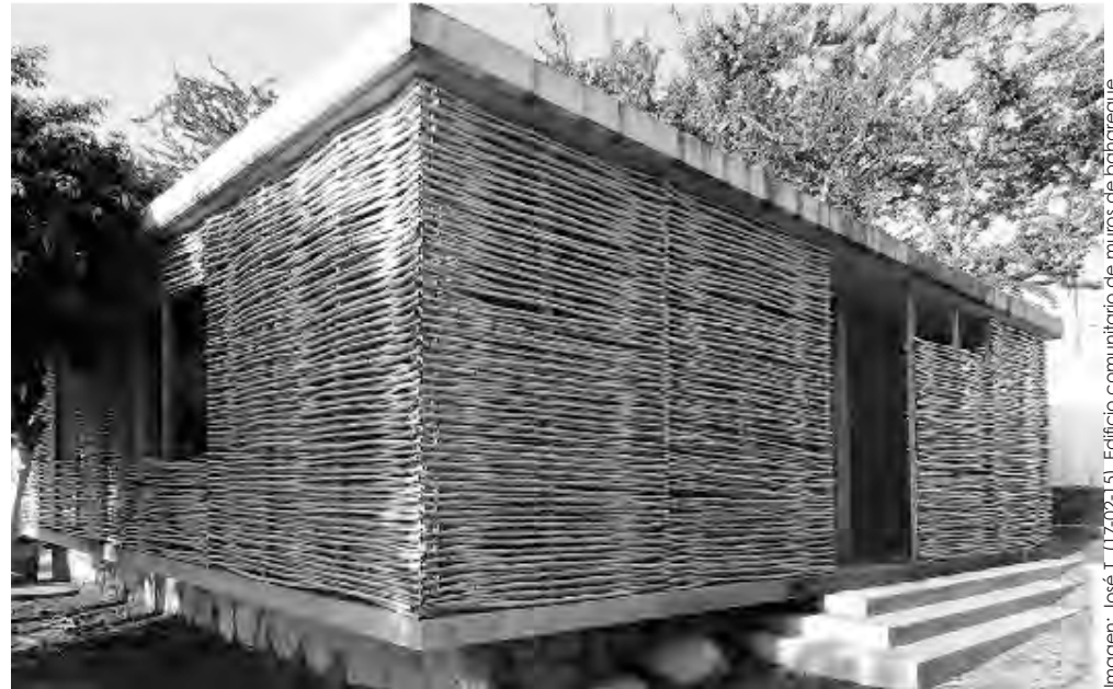
Construcción con carrizo.
