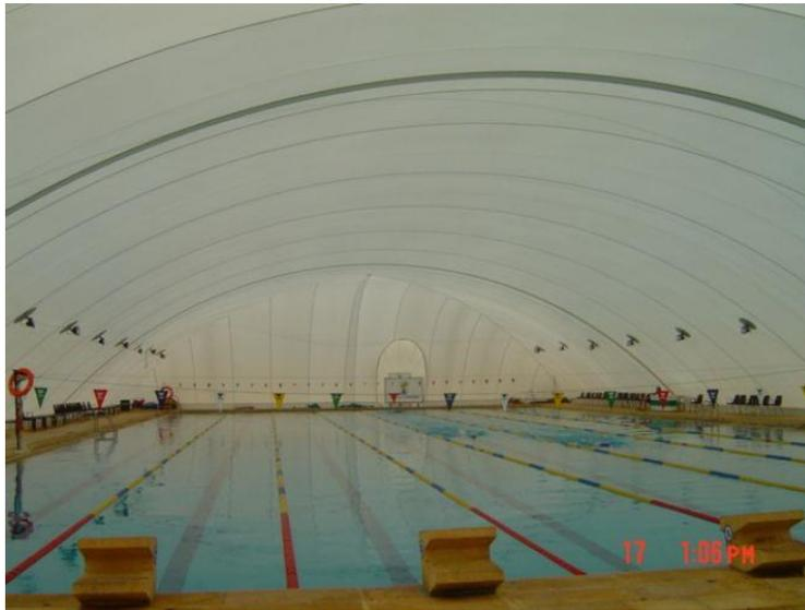
*Figura 9. Cubierta hinchable Presostática CN Montjuic (España)<sup>9</sup>*
