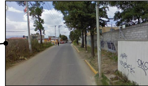
Camino a la Presa
