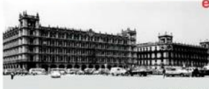
EDIFICIO DEL GOBIERNO MUNICIPAL
