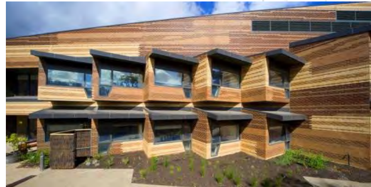
Fotografía tomada de ArchDaily 6 diciembre, 2015 Centro Mornington, fachada sur.
