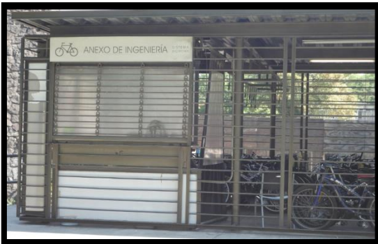
Módulo Anexo de Ingeniería
