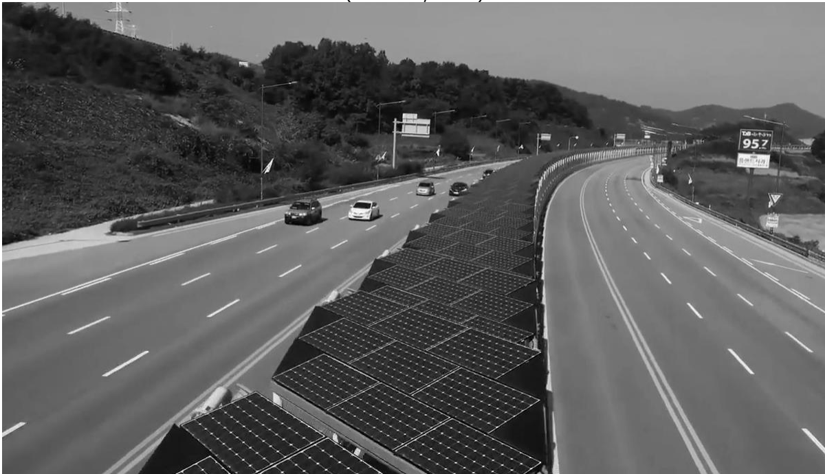
Figura 7.1b. Carril de bicicletas con cubierta solar entre Daejeon y Sejong, Corea (City of Sejong, 2017)
