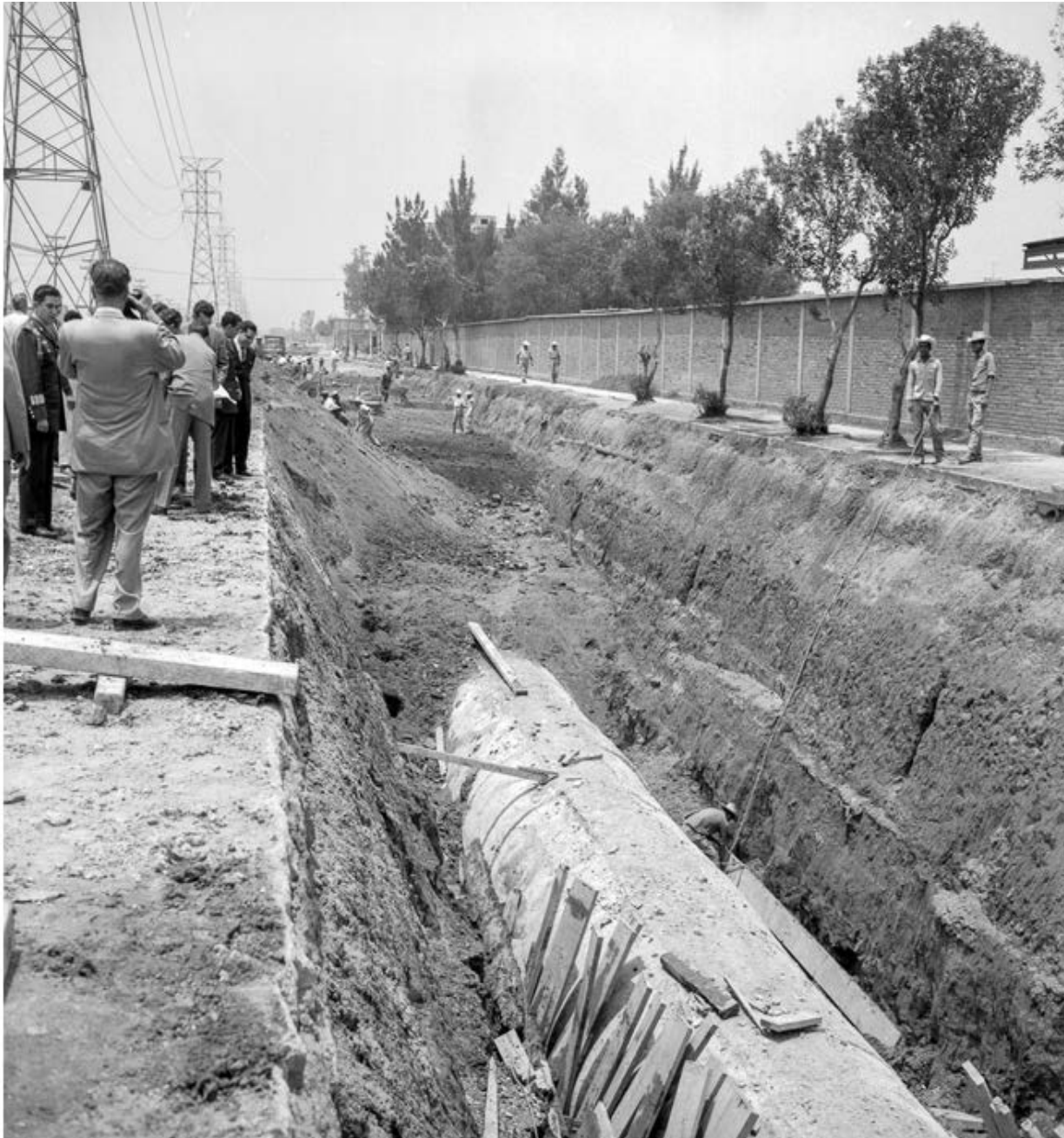
Imagen 39. Construcción de un Viaducto en el Anillo periférico, Anónima, Fondo Casasola, INAH, 1961.
