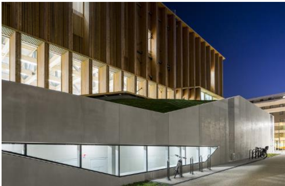
Fachada del Centro Deportivo en Neudorf. Atelier Zündel Cristea. (2014). Centro deportivo en Neudorf / Atelier Zündel Cristea. Febrero 3,2016, de arquitectura Sitio web: https://www.archdaily.mx/mx/781372/centro-deportivo-en-neudorf-atelier-zundel-cristea
