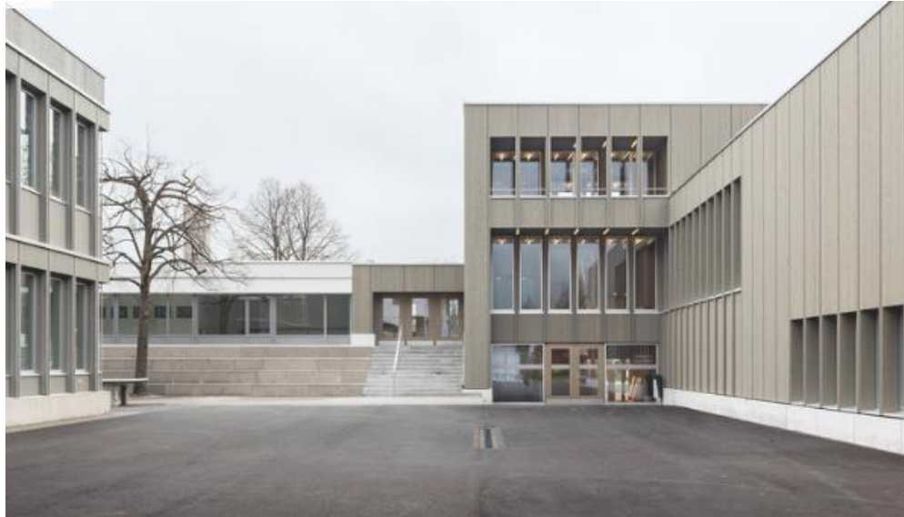
Fachada del Deportivo Balzers. BBK Architekten. (2016). Renovación salón deportivo Balzers / BBK Architekten. Marzo 30, 2017, de arquitectura Sitio web: https://www.archdaily.mx/mx/867938/renovacion-salon-deportivo-balzers-bbk-architekten
