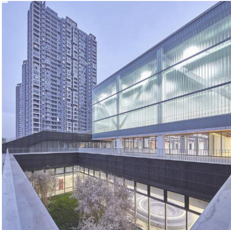
Fachada del Centro Deportivo Comunitario San Wayao en China. CSWADI. (2015). Centro Deportivo Comunitario San Wayao / CSWADI. JULIO 6, 2015, de ARQUITECTURA Sitio web: https://www.archdaily.mx/mx/769721/centro-deportivo-comunitario-san-wayao-cswadi?ad_medium=widget&ad_name=navigation-prev
