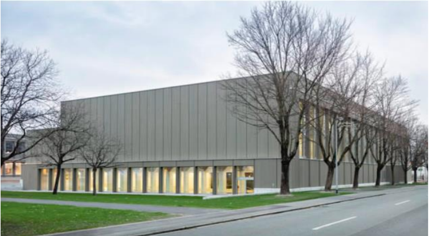
Fachada del Deportivo Balzers. BBK Architekten . (2016). Renovación salón deportivo Balzers / BBK Architekten . Marzo 30, 2017, de arquitectura Sitio web: https://www.archdaily.mx/mx/867938/renovacion-salon-deportivo-balzers-bbk-architekten
