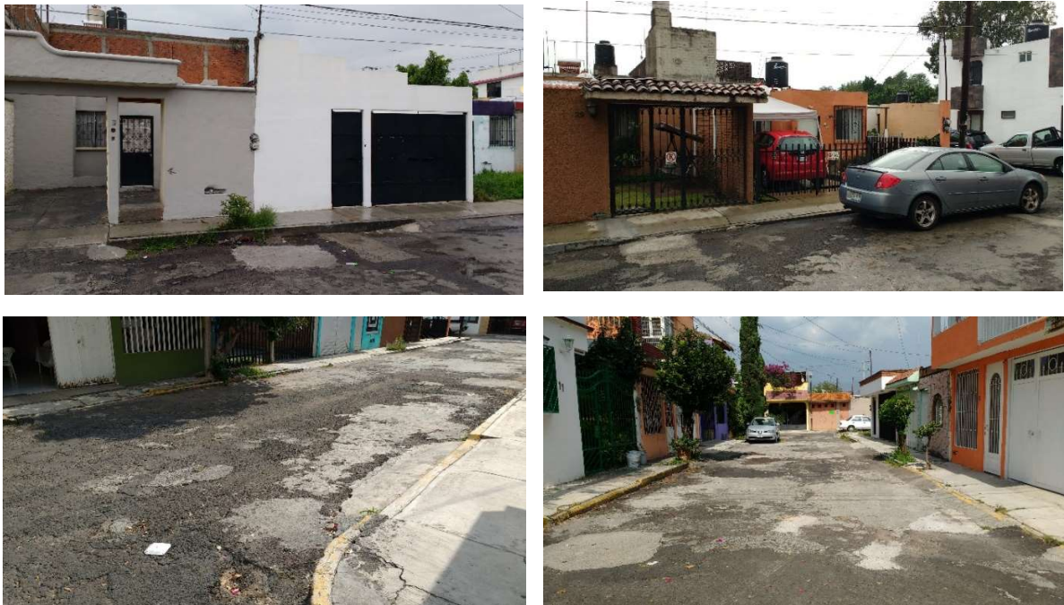
Figura 5.5 Condiciones físicas de las calles del bloque de viviendas de la zona baja
