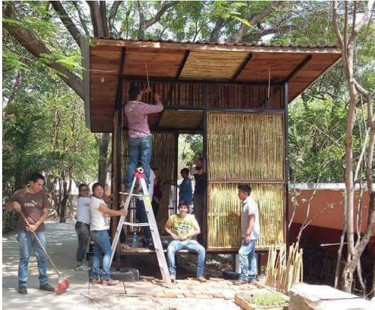
Fig. 156. Alumnos de la Fac. de Arquitectura de la UNACH construyendo un módulo habitable, con tecnología regional, materiales industrializados y de reuso.
