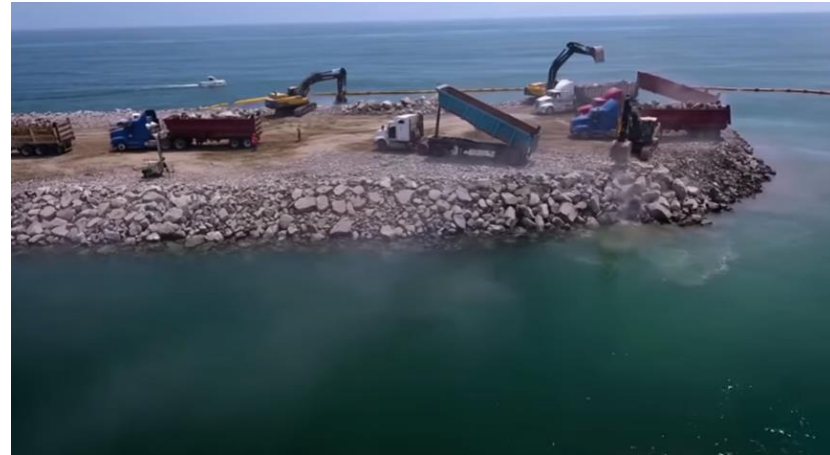
Construcción de terminales e instalaciones
