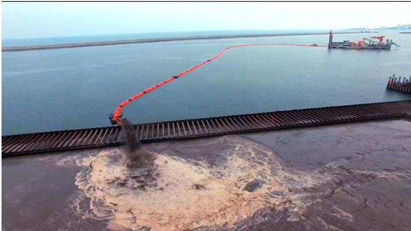
Obras de protección y vialidades
