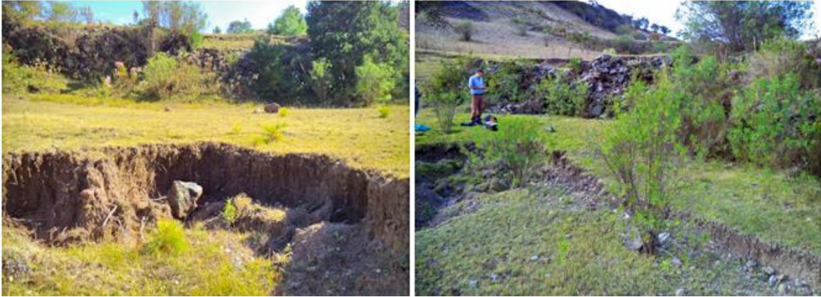
Figura 6.5 Asentamientos de terreno en lamabordos del sistema Panteón (izq., MIX 09.) e Ichiyodo (der. MIX 08)
