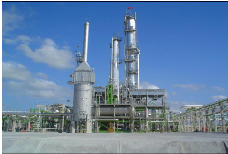
Figura 1. 9. CPG Burgos (PEMEX GAS Y PETROQUÍMICA BÁSICA, 2015)
