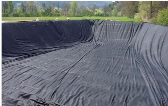
Figura 10. Geomembrana en un lago artificial.
