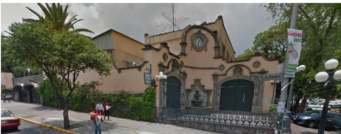
7.6 Exhacienda Tlalpan, vista desde Calzada de Tlalpan (Fotografía). Año 2015. Fuente: www.google.com.br/maps
