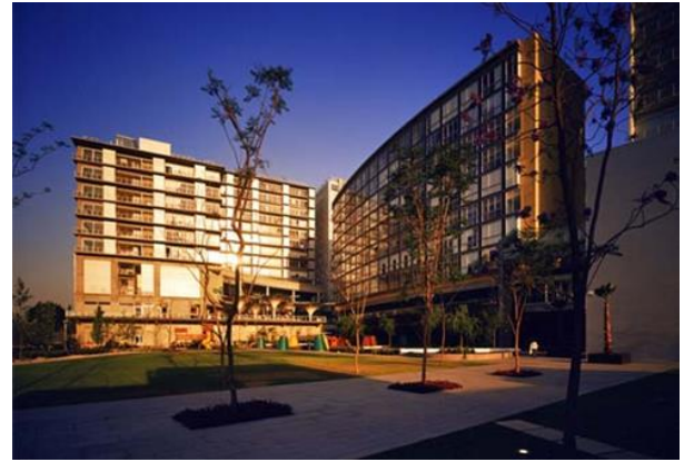
2.2 Vista exterior Parques Polanco (Fotografía) Año 2015. Fuente: www.parquespolanco.com
