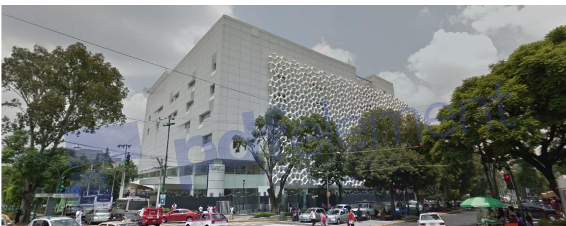
7.5 Hospital GEA González, vista desde Calzada de Tlalpan (Fotografía). Año 2015. Fuente: www.google.com.br/maps
