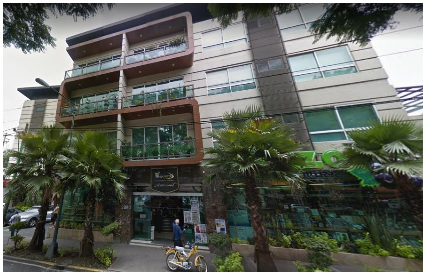
Fuente: Google maps. Street view Septiembre 2017.
