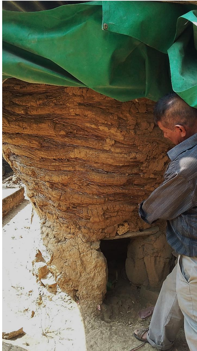
Figura 14. Cuexcomate. Estructura construida con barro y zacate que se usa para el almacén de granos. Fotografía: Bárbara Puente Uribe. Amatlán, abril de 2017.
