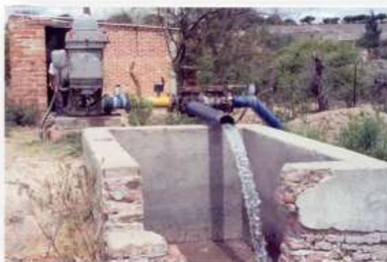
**Ilustración 14:** Pozo de Riego agrícola sobreexplotado (el tubo del agua no se alcanza a cubrir está bajo en su rendimiento). Imagen: Proporcionada por el Consejo Técnico de Aguas de Río Laja
