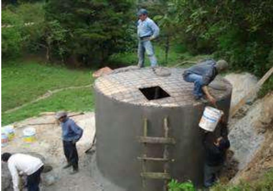
**Ilustración 20:** Ingeniero Alejandro Buenrostro, Presentación Power Point, 2016, cisterna de ferrocemento para el almacenamiento de agua.
