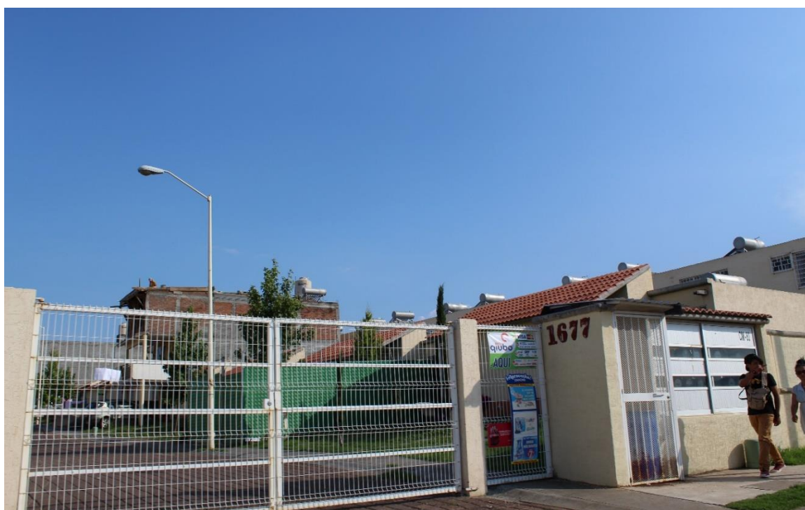
Anexo 2.2.15 Reja de acceso a las privadas de San Pedro
