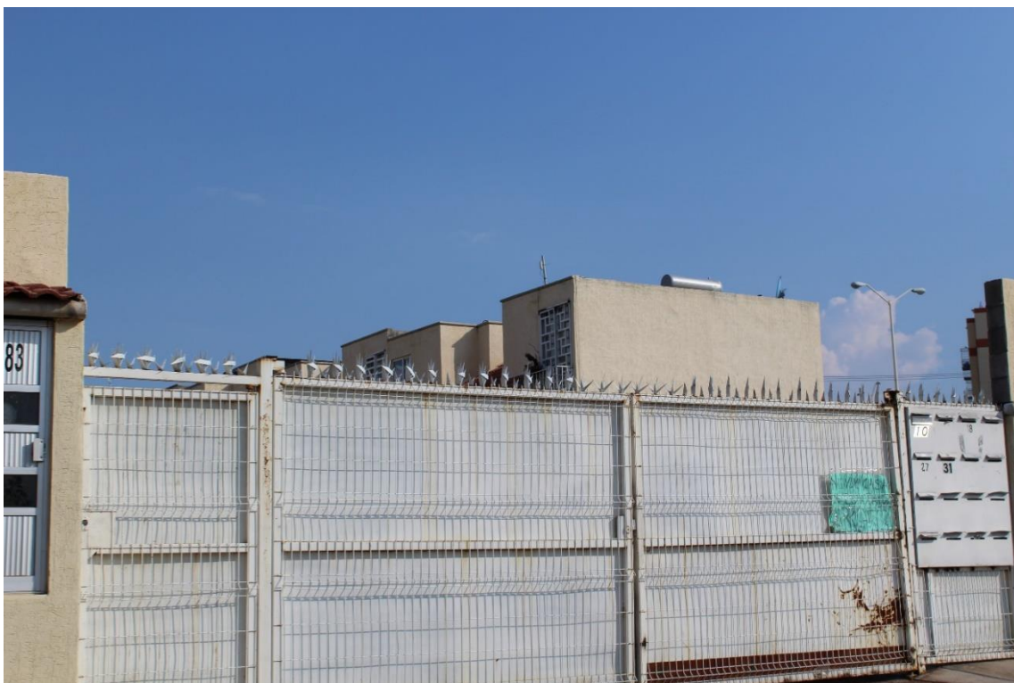
Anexo 2.2.14 Reja de acceso a los cotos con púas en la parte alta de la reja. Una herramienta extra para protección de la privada en San Pedro
