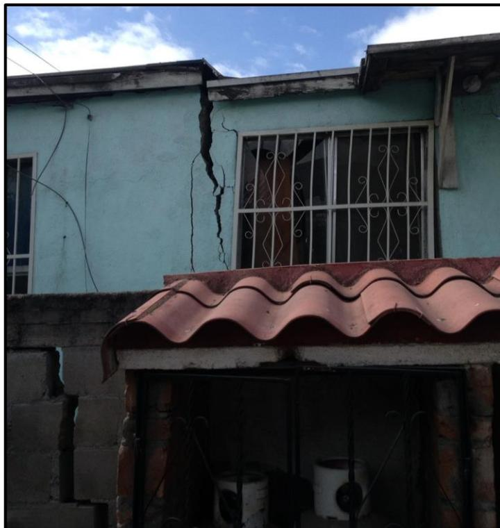
Figura 33. Daños reflejados en una vivienda de la colonia Sánchez Taboada (Proporcionada por la Dirección de Protección Civil Municipal).
