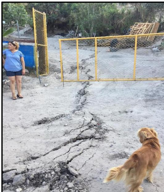
Figura 31. "Levantamiento" del terreno en la colonia Reforma. Derivado del movimiento de ladera del 2018.
