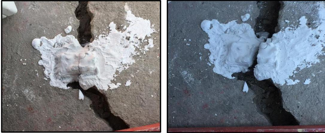
Figura 42. Testigo colocado en la colonia Reforma de la ciudad de Tijuana. En la imagen de la derecha se puede observar el movimiento de la grieta reflejado en el testigo.
