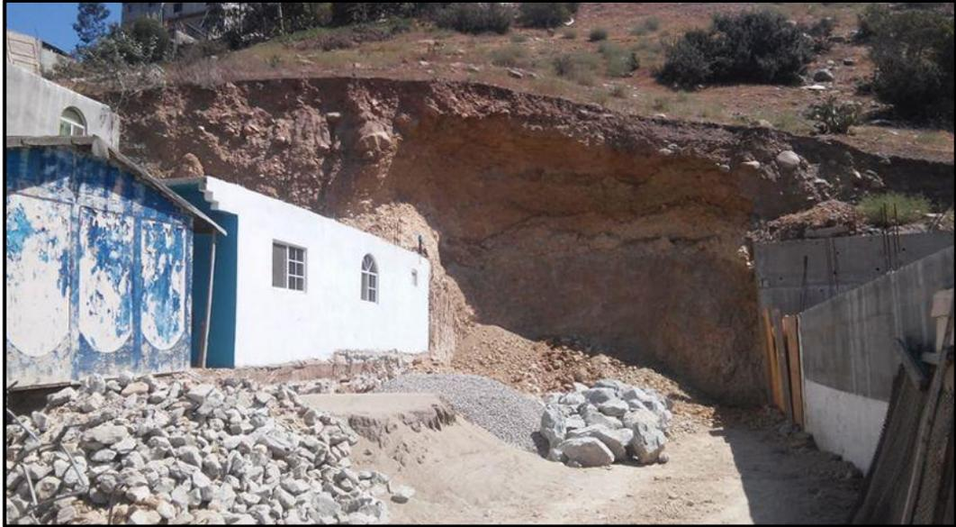
**Figura 27. Corte al pie de una ladera en la colonia Pedregal de Matamoros, Tijuana, B.C. Producto de dicho trabajo irregular y sin supervisión resultaron 5 viviendas dañadas en septiembre 2018 (Uniradio, 2018).**
