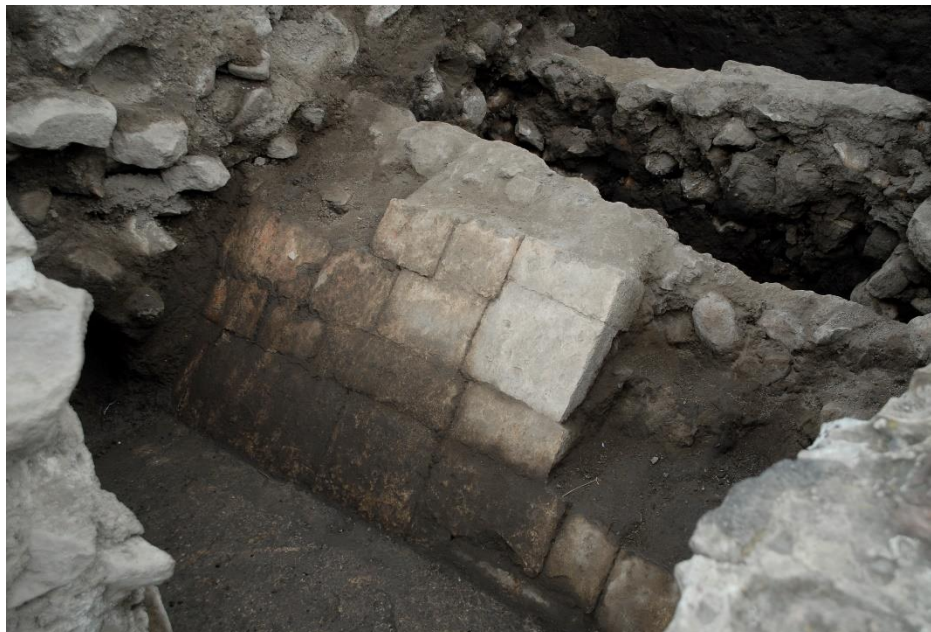
FOTOGRAFÍA 5 Talud tipo mosaico localizado al interior de la escalinata del edificio 9.n3e1, en contacto con el Piso Planco.
