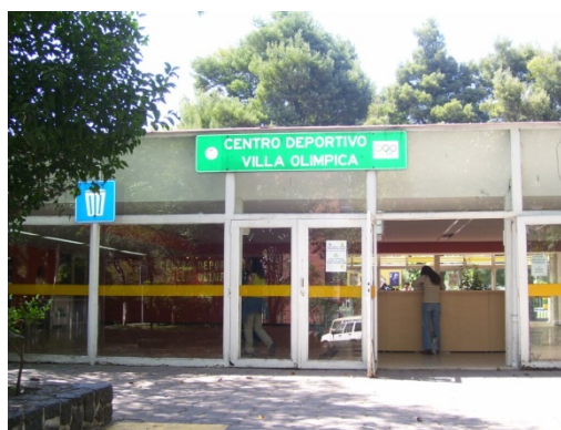
Acceso al edificio principal
