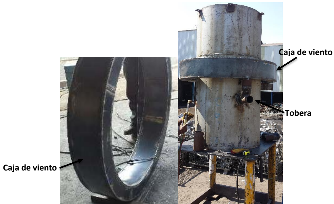
Figura 13. Construcción de la caja de viento y zona de toberas.
