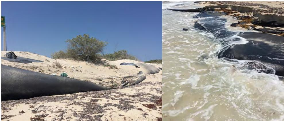
*Figura 4. Situación actual del geotextil en zonas críticas.*
