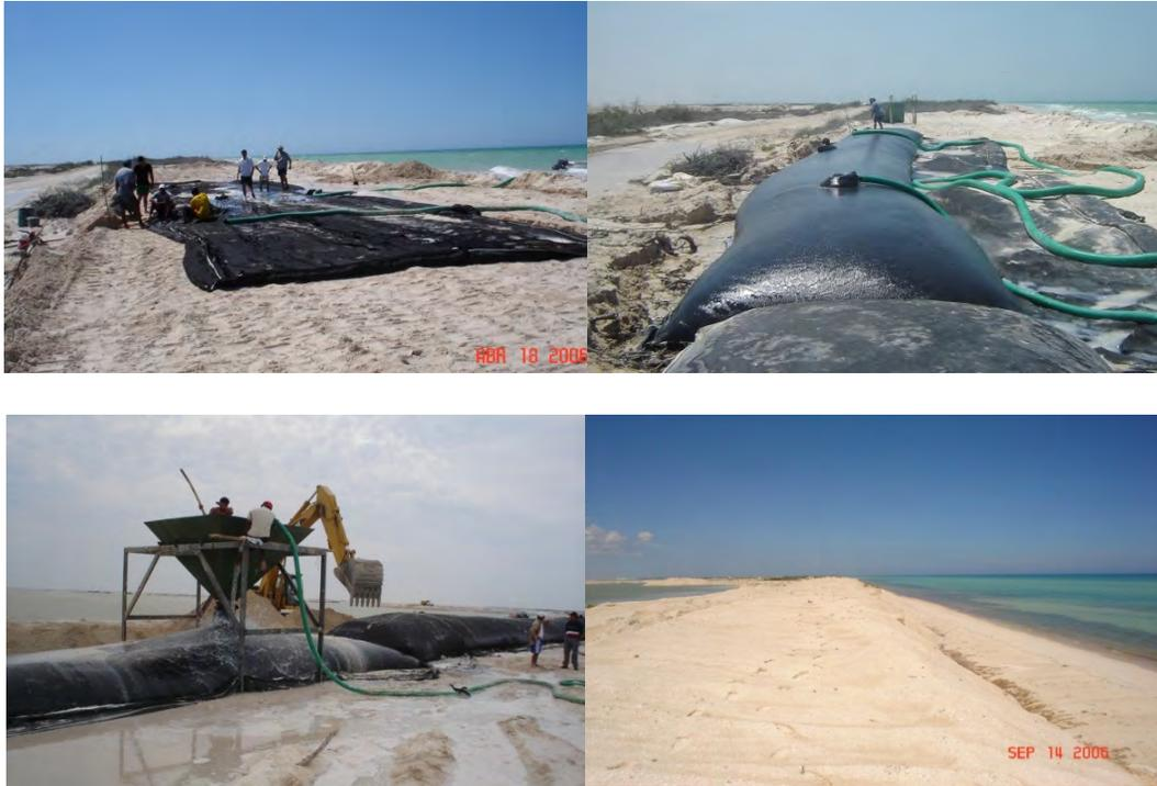
*Figura 3. Proceso de instalación de geotextiles para la duna costera.. Fuente: Axis ingeniería (2006)*
