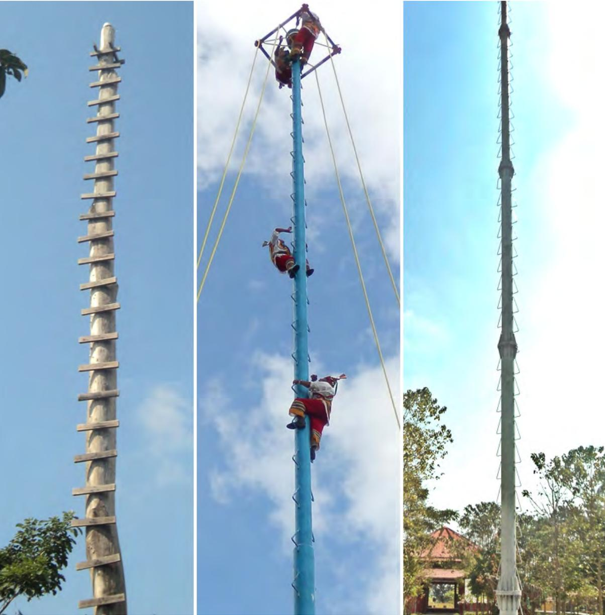
Foto 11. Mástil. Izquierda, madera. Centro, metal, soldado. Derecha, metal, atornillado.
