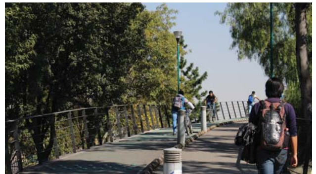
F Puente entre Instituto de Física e Instituto de Geofísica PENDIENTE DE 4° CON UNA LONGITUD DE 131 METROS
