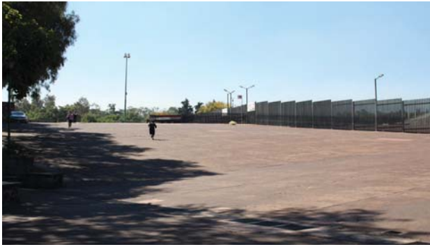
A Acceso al Estadio Olímpico y estacionamiento N°. 8 PENDIENTE DE 7° CON UNA LONGITUD DE 55 METROS
