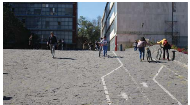
D Corredor que conecta la Fac. de Economía con la de Medicina PENDIENTE EMPEDRADA DE 7.5° CON UNA LONGITUD DE 21 METROS
