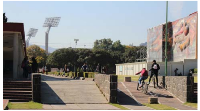
B Corredor frente a la Facultad de Arquitectura PENDIENTE DE 10° CON UNA LONGITUD DE 6 METROS
