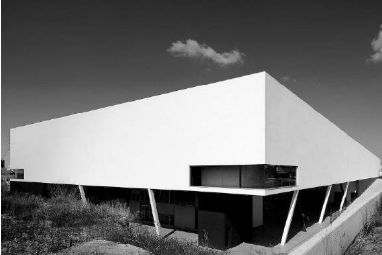
Imagen 3.6 Fachada principal del proyecto Escuela de Música en Lisboa. Fuente FG+SG Fernando Guerra
