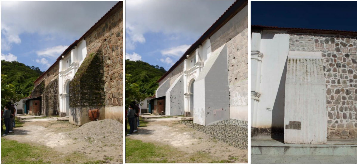
Fachada poniente del templo de Yatzachi el Alto, las imágenes muestran la propuesta de intervención de encalado de muros en la siguiente secuencia: estado en 2010, proyecto de restauración 2011, estado en 2015.
