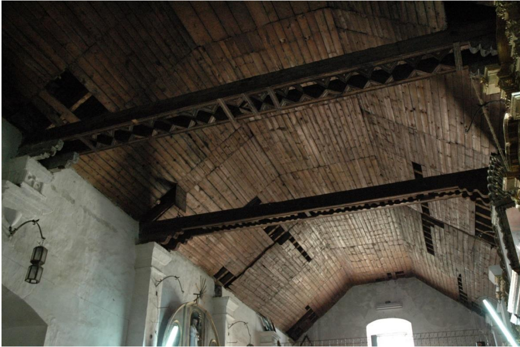
Detalle de cubierta original antes de su transformación, Santiago Zochila.
