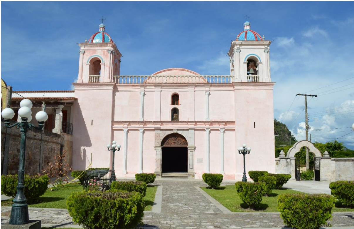
Fachada estado actual posterior a una reintegración de aplanados y aplicación de pintura a la cal San Francisco Caxonos
