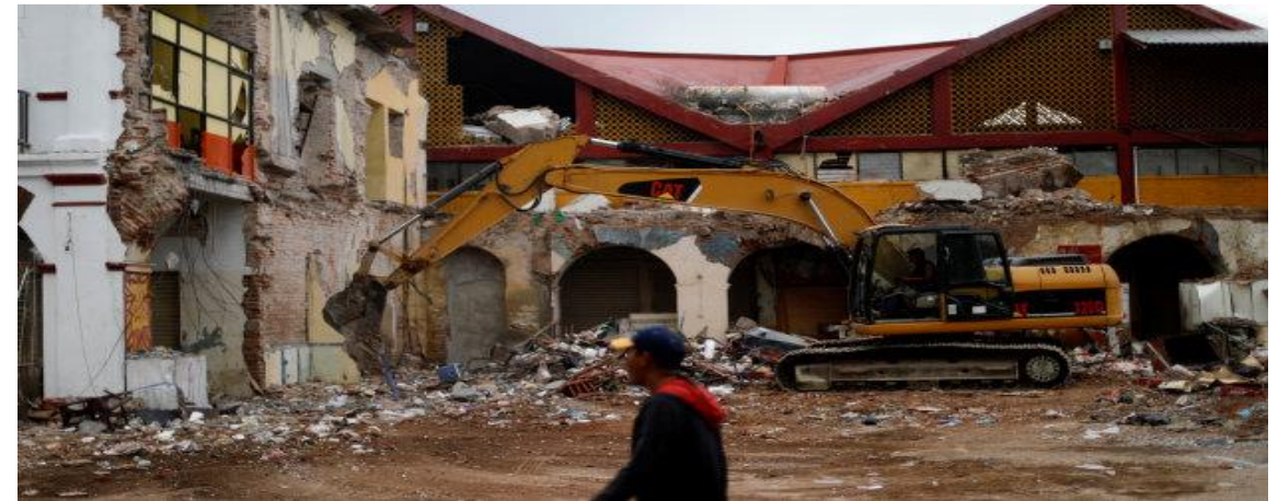
VIVIENDA DESPUÉS DEL SISMO FUENTE: Google
