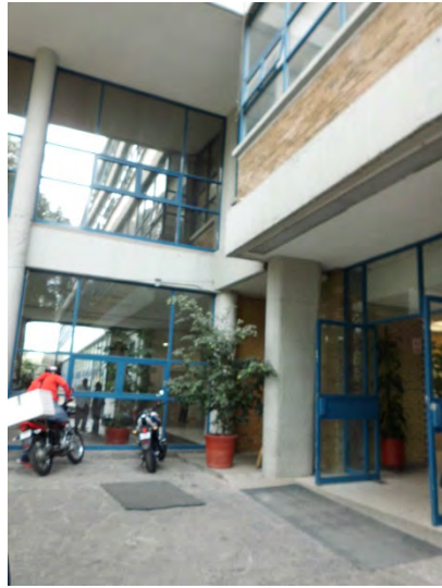
Imagen 3.6. "Fotografía del acceso noreste del edificio C de la facultad de Odontología". Elaborado por, Nami Ota, en enero 2014
