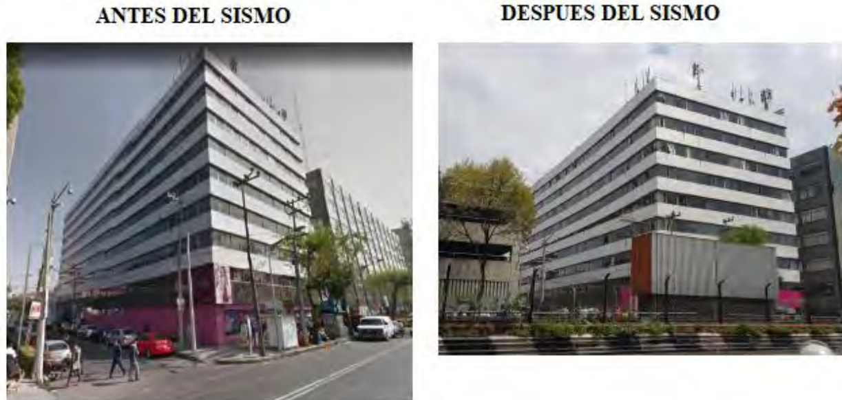
Figura 4-1 Edificio ISSTE, Calzada San Antonio Abad 122, Año de construcción 1987. Fuente: Visualizador de inmuebles con daños para la Ciudad d México, ERN
