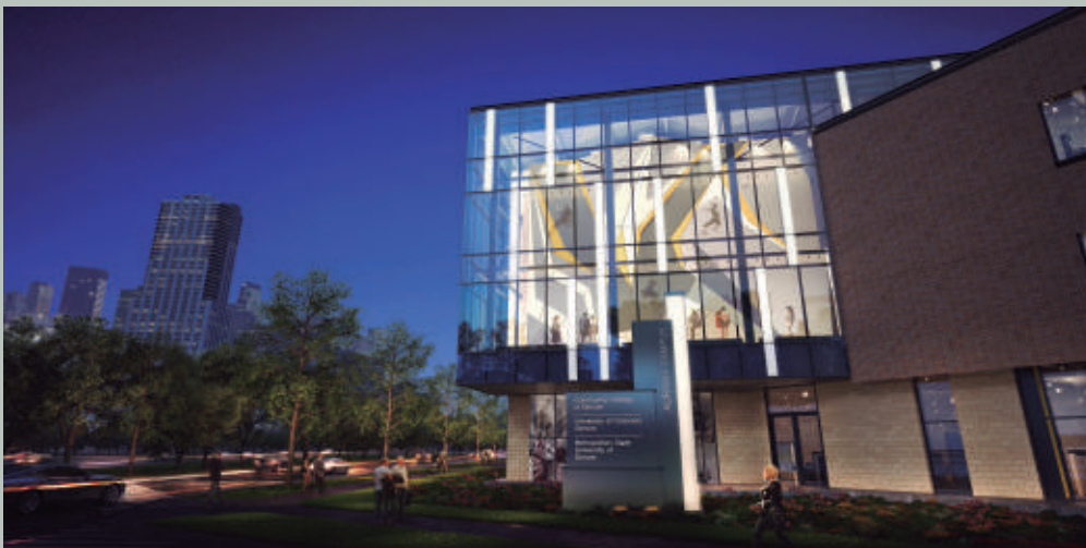
Imagen 27. Sala de usos múltiples, Anschutz Health and Wellness Center
