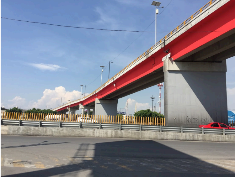
Ilustración No. 31 Estructura para la movilidad vehicular.
