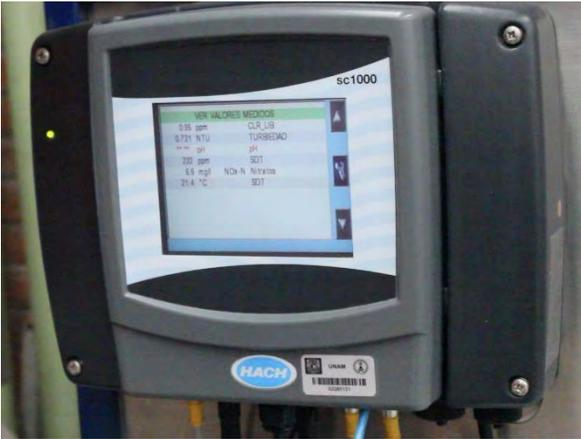
Posteriormente para conocer la calidad del agua se utiliza un sistema de monitoreo en tiempo real que mide: turbiedad, sólidos disueltos totales, nitratos, PH, cloro residual libre y temperatura. Estos sensores arrojan información cada 5 minutos de la calidad y concentración de los parámetros que se miden, con el fin de poder tener un
