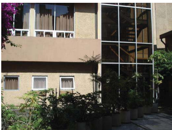
38. El edificio más nuevo de los tres de que consta el CUEC, tiene una antigüedad de 15 años. En este se concentran principalmente las actividades de edición, así como de directores de área
