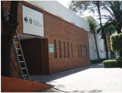
Acceso al CCC sobre Av. Río Churubusco
