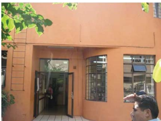
37. El acceso al edificio principal, que alberga las actividades administrativas y académicas esta dado a través de un pasillo desde el pórtico de acceso hacia el interior del conjunto.
