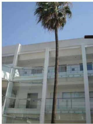
Vista de los pasillos del edificio de aulas
