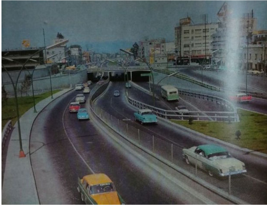
Figura 3.4 “Solución técnica que intercomunica el Viaducto Piedad, La Avenida Revolución, Parque Lira y el Periférico”. 141
