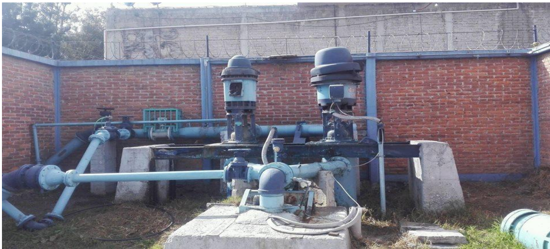
Ilustración 17: Configuración de los accesorios y del sistema de bombeo que tiene actualmente el pozo (S-6) que alimentará la línea de conducción de la localidad “El Capulín”.
