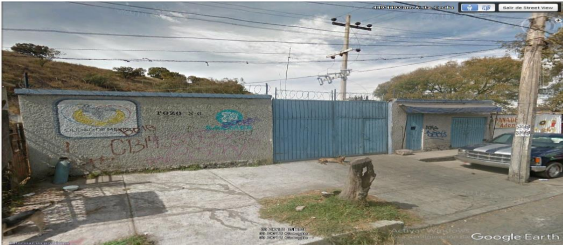
Ilustración 16: Vista exterior del pozo S-6.
