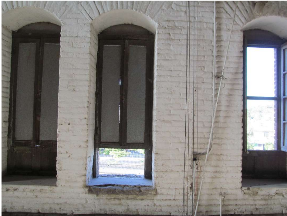
Figura 112. Archivo M.A.R.C. Ventanas fachada principal tercer nivel.
