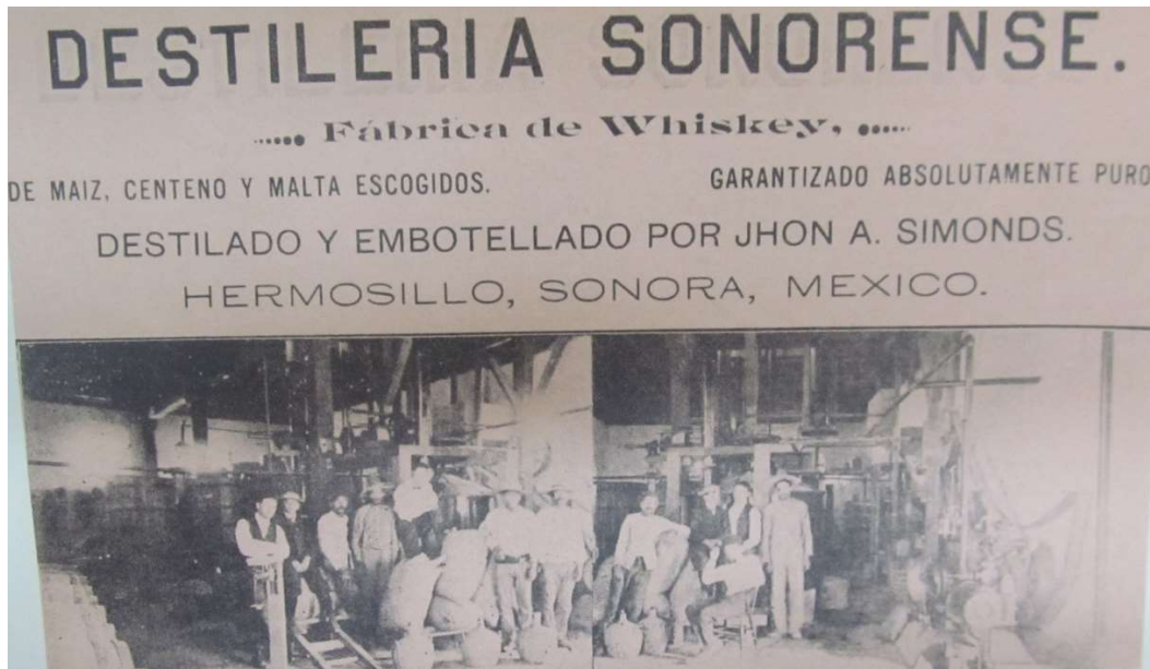
Figura 19. Historia General de Sonora, IV Sonora Moderno: (1880-1929) . Hermosillo: Gobierno del Estado de Sonora, 1985. Anuncio de fábrica de Whiskey en Hermosillo, Sonora, 1905. Utilización de madera al interior.
