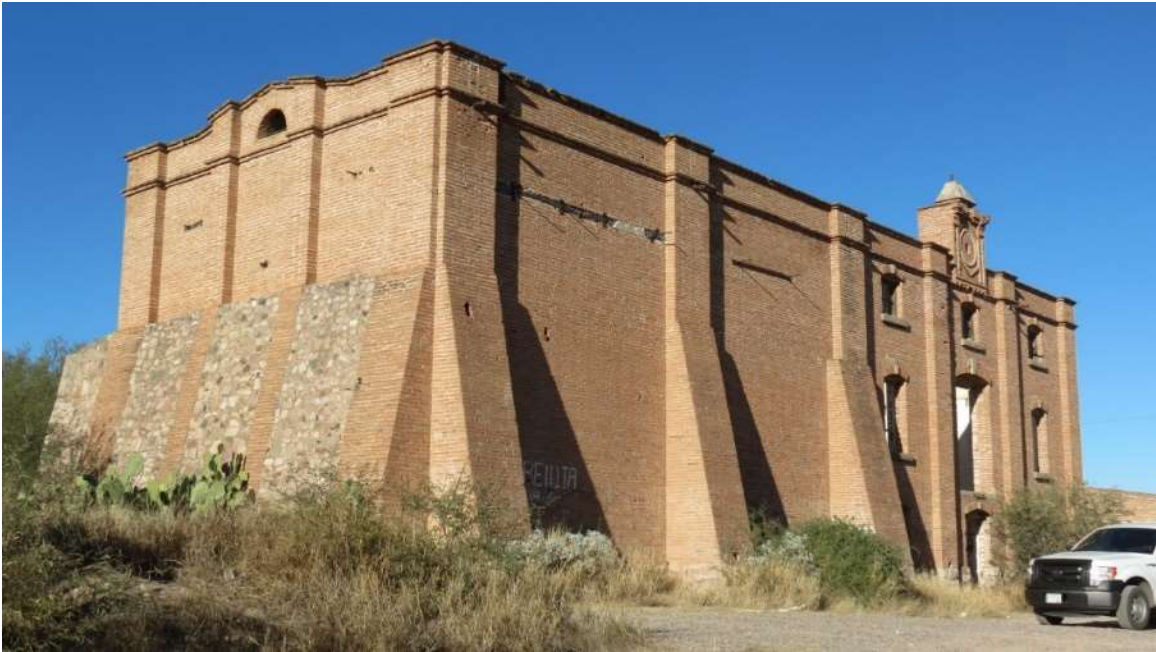
Figura 29. Molino harinero “El Fénix”, año 2016. Archivo M.A.R.C. Este edificio era un molino harinero construido de ladrillo de media caña, su maquinaria funcionaba por medio de una turbina movida por energía hidráulica. Algo significativo en su fachada principal es la colocación de un reloj monumental.
