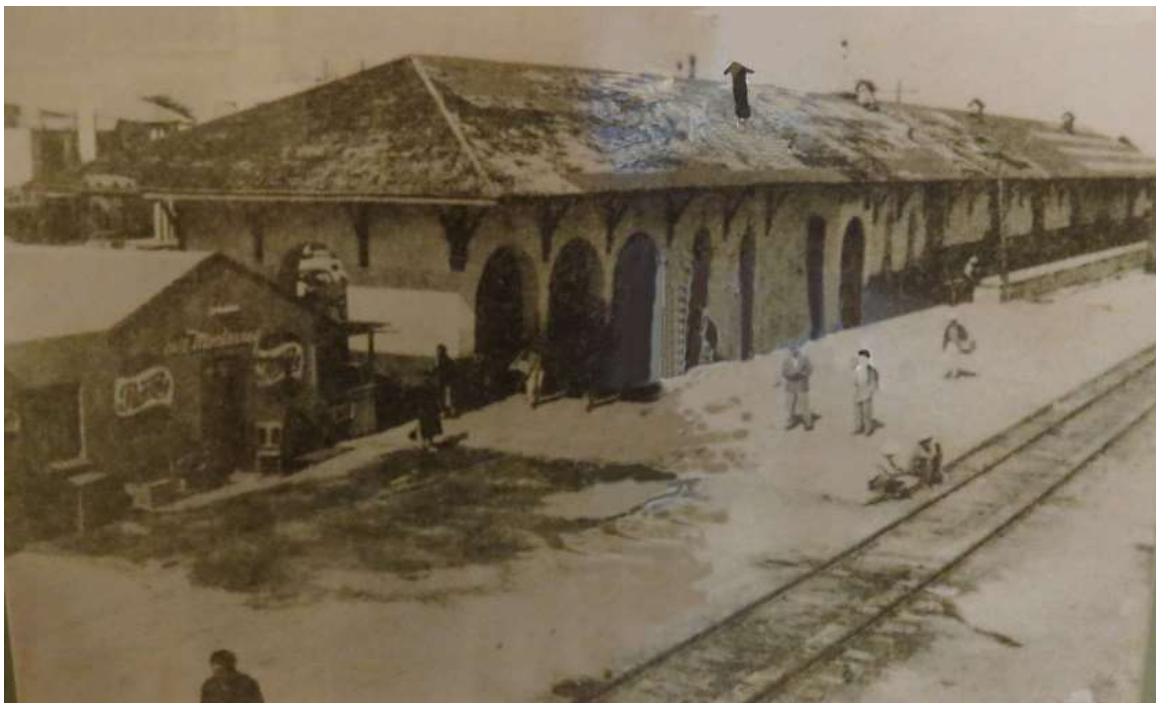
Figura 03. Archivo Radio Sonora https://radiosonora.com.mx/ . Desaparecida estación del ferrocarril, construida con muros de mampostería, estructura interior de madera que sostiene la cubierta, al exterior ménsulas que probablemente hayan sido de acero.
