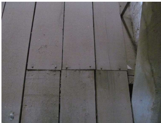
Figura 115. Archivo M.A.R.C. Entablado del mezzanine, con unión de acero, las piezas ya no se ajustan bien a causa de que ha cambiado su volumen por el clima desértico.
