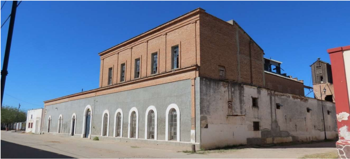
Figura 31. Molino “El Urense”. Año 2016. Archivo M.A.R.C. Este inmueble ya corresponde su construcción al siglo XX y contaba con alta tecnología para su época de construcción en maquinaria para la producción de harina de trigo y ésta funcionaba por medio de energía eléctrica. Al igual que los ejemplos anteriores, está construida de ladrillo de media caña pero en el diseño se realizó la combinación de texturas y acabados y tipos de ventanas.
