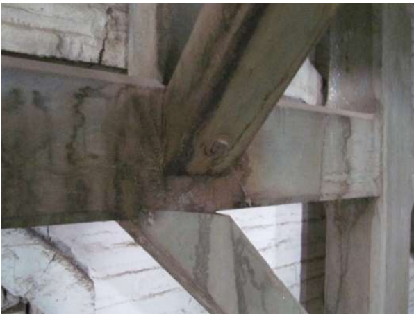
Figuras 73 y 74. Archivo M.A.R.C. En la estructura de la cubierta en la crujía norte, algunas uniones que se utilizaron fueron de acero.
