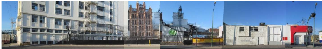
Figura 98. Estado actual. Fachada norte del conjunto de la producción de harina del molino la fama
