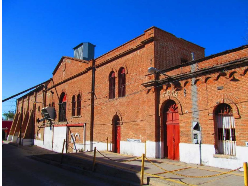
Figura 25. Antiguo molino “La Fama” y posteriormente llamado molino “Moderno”. Año 2015. Archivo M.A.R.C. este inmueble se ubica en el antiguo barrio de Villa de Seris, que hoy forma parte de la ciudad de Hermosillo, construido de ladrillo de media caña y funcionaba por medio de una turbina movida por energía hidráulica gracias a la acequia que pasaba al norte de este edificio.
