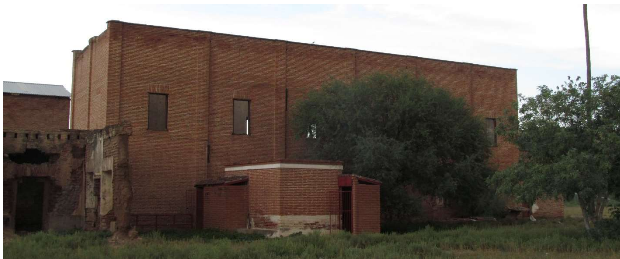
Figura 08. Molino perteneciente a la antigua hacienda de Camou, dentro del municipio de Hermosillo. Construido a mediados del siglo XIX. Trabajaba por medio de una turbina movida por energía hidráulica. Archivo M.A.R.C.
