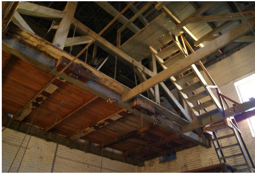
Figura 68. Archivo M.A.R.C. A la derecha la escalera de acceso al mezzanine, izquierda entrepiso del mezzanine. Se aprecia la moderna solución estructural con construido de madera, por medio de viguerías, tableados, armaduras.
