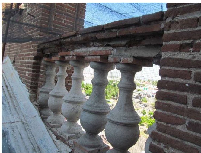
Figura 108. Archivo M.A.R.C. Detalle de balaustrada y cornisa superior del lado oriente de la fachada principal.
