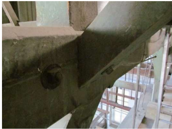
Figuras 73 y 74. Archivo M.A.R.C. En la estructura de la cubierta en la crujía norte, algunas uniones que se utilizaron fueron de acero.
