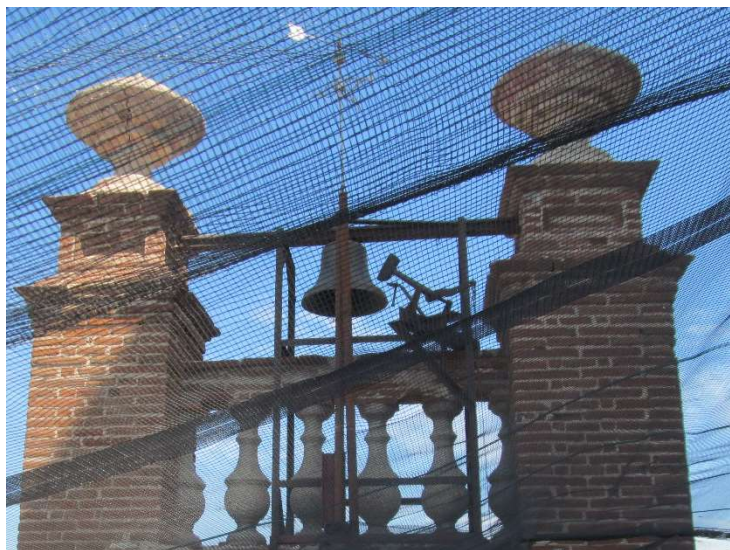
Figura 109. Archivo M.A.R.C. Carrillón del reloj monumental soportado por estructura tubular de acero, ubicado junto a la balaustrada del centro del remate de la fachada principal.
