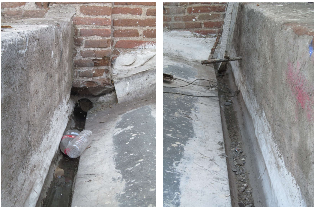
Figura 105 y 106. Archivo M.A.R.C. Canaletas para drenaje pluvial en crujía norte.
