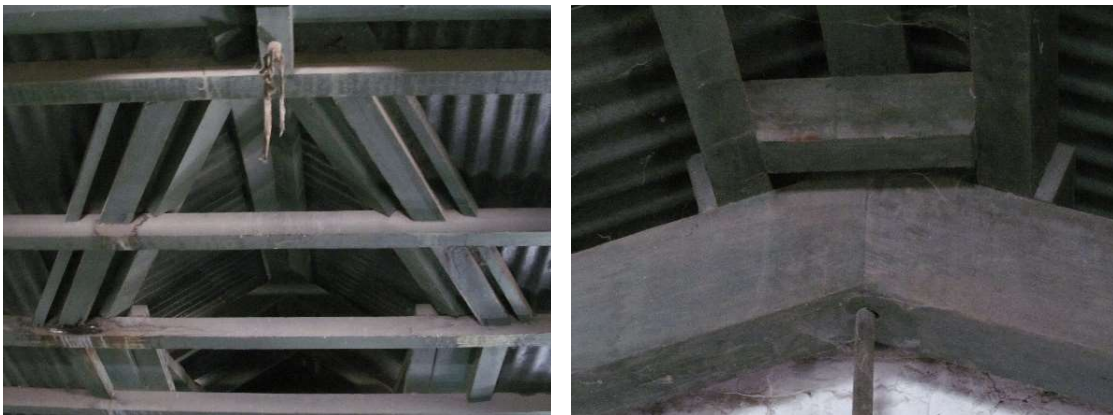
Figuras 69 y 70. Archivo M.A.R.C. Imagen de la izquierda es el cruce de los largueros con la estructura interior de la buhardilla.
