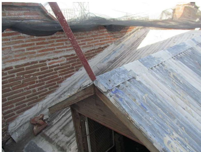
Figura 107. Archivo M.A.R.C. Cubierta de la buhardilla, al fondo cubierta de la crujía norte y muro de ladrillo (tabique) que divide la crujía norte de la crujía sur.
