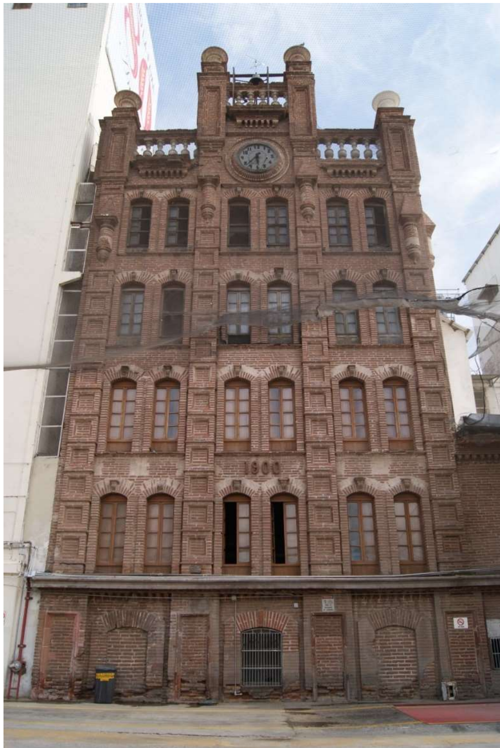
Figura 94. Fachada principal del molino en julio de 2015. Archivo M.A.R.C.
