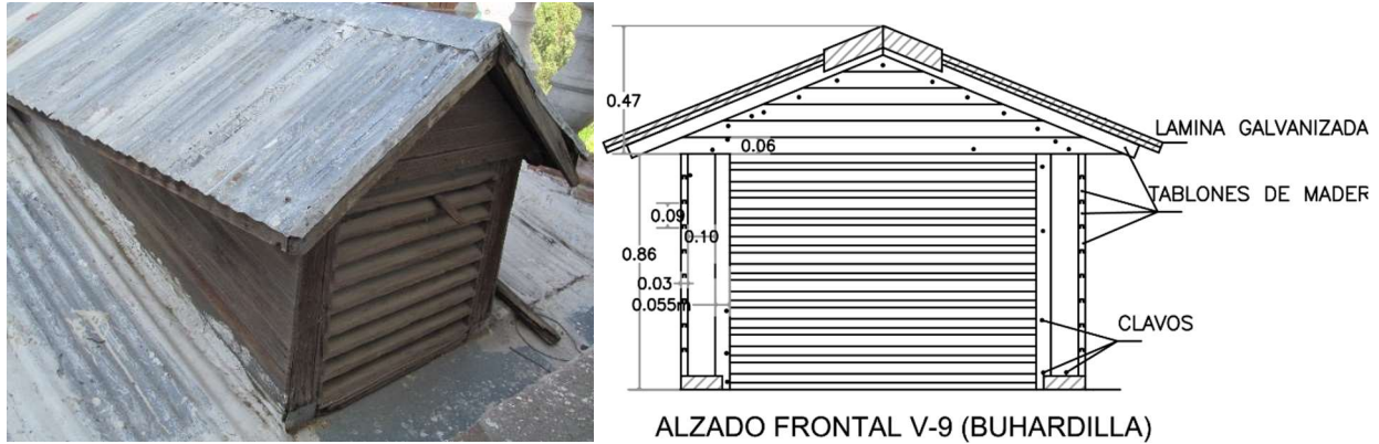
Figura 75 y 76. Archivo M.A.R.C. Buhardilla y persiana de la misma, construidos de madera, a excepción de la cubierta que es de lámina galvanizada.
