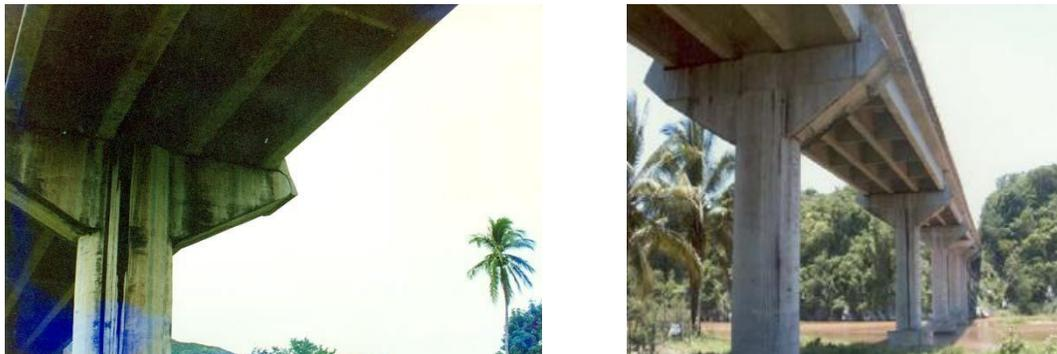
Figura 1.8 Daños en el puente Nexpa durante el sismo de Tecomán, 2003 (Hernández, et al 2014)
