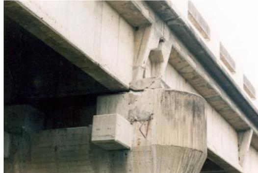
Figura 1.11 Daños en topos sísmicos del puente Cihuatlán (Hernández, et al 2014)
