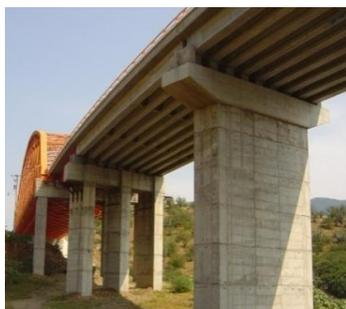
(a) Columnas y cabezales de geometría variable.
