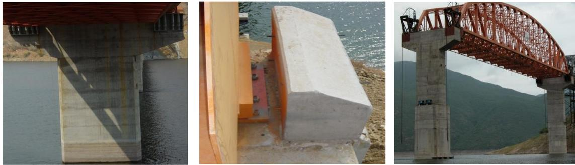
(a)Pila sección rectangular, cabezal sección variable. (b) Topes sísmicos en pilas, sección irregular. (c)Pila sobre tapa de cilindro de concreto.
