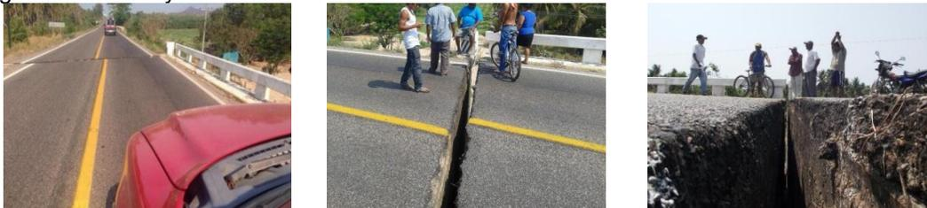
Figura 1.14 Daño en puente las Tortugas (Hernández, et al 2014)
