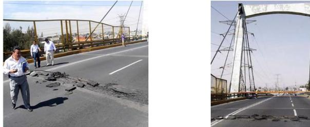
Figura 1.13 Daño en puente República federal
