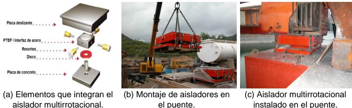
Figura 5.1 Aislador multirrotacional colocado en puente Infiernillo II
