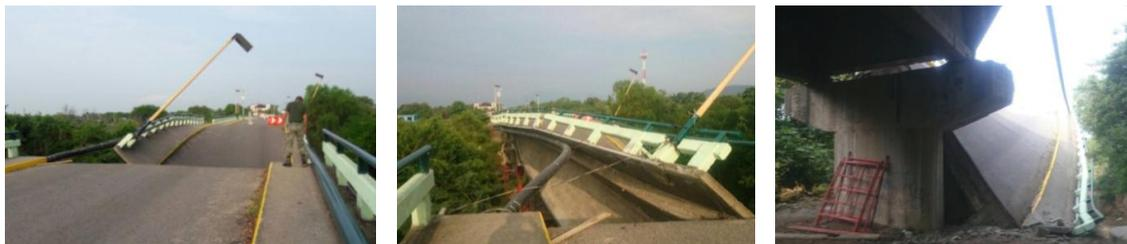
Figura 1.19 Colapso en puente Ixtaltepec (Fuente: [www.yahoo.com.mx](http://www.yahoo.com.mx))
