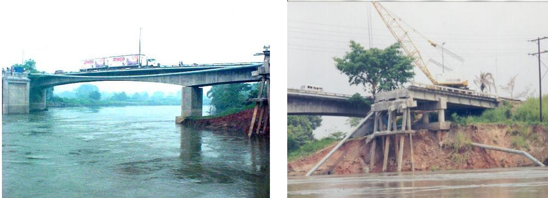
Figura 1.6 Colapso de la pila 5 y fractura del caballete 6, puente La Pigua (Frías, et al 2014)
