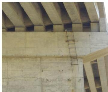
(b) Topes sísmicos en pilas, sección rectangular.
